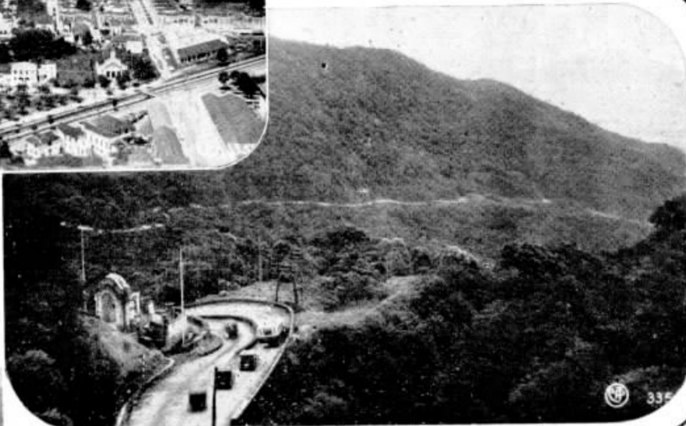
Vista da estrada que corta a Serra, no ponto onde existiu a celebre "curva da morte". Vêem-se as linhas telephonicas interurbanas que ligam S. Paulo a Santos.
